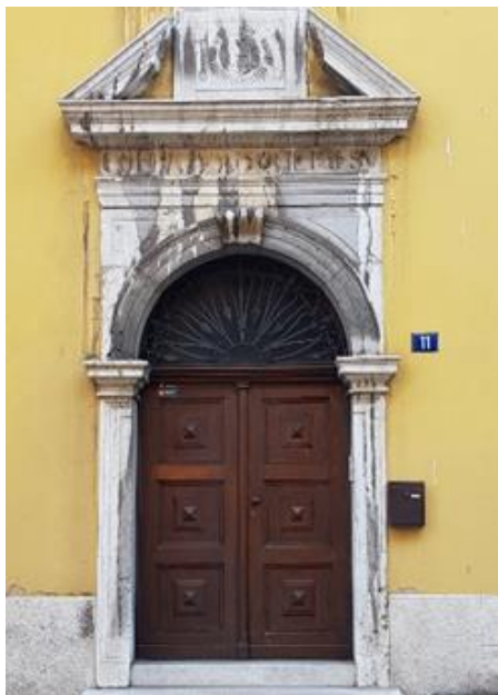
Slika 135. Nekadašnji portal na zgradi kolegija , sredina 17. stoljeća, rektorov stan, Rijeka, foto: M. Pintarić
