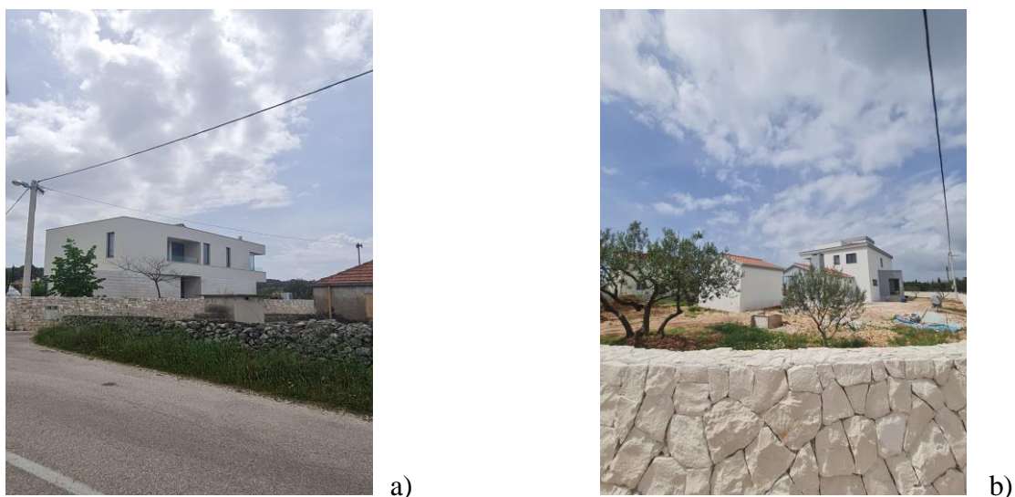
Slika 11. Primjer izgradnje modernih kuća u Žednom (a, b)
