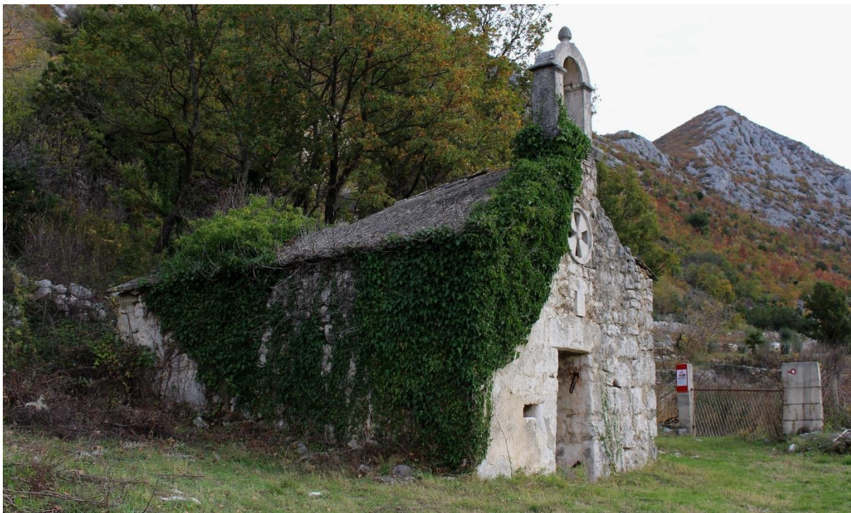
Prilog 1. Fotografija, Gospa od Zdravlja prije izvedbe radova – pogled sa zapada. Autor fotografije: Izv. prof. dr. sc. Željko Miletić
