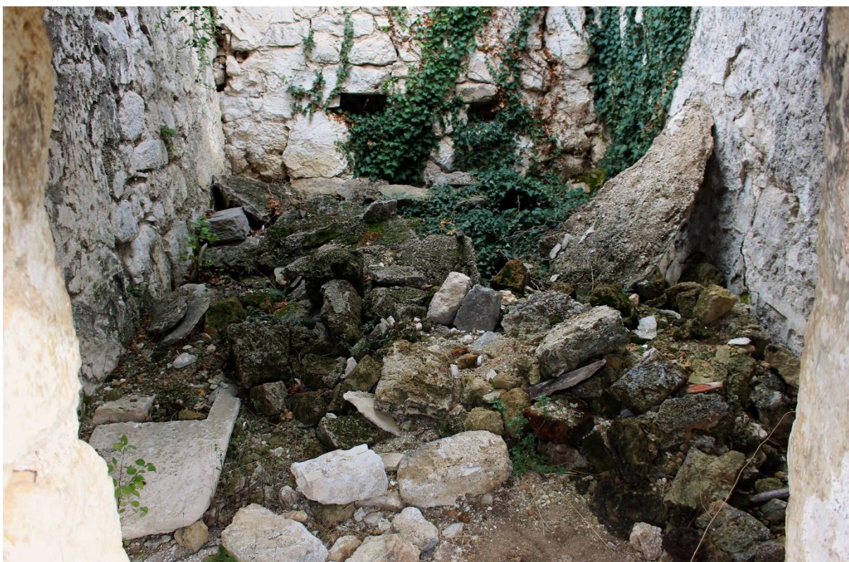
Prilog 7. Fotografija, unutrašnjost prije izvedbe radova. Autor fotografije: Izv. prof. dr. sc. Željko Miletić
