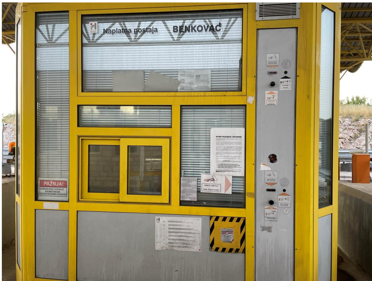
Slika 9 Ulazna staza s automatiziranim davačem magnetskih kartica
