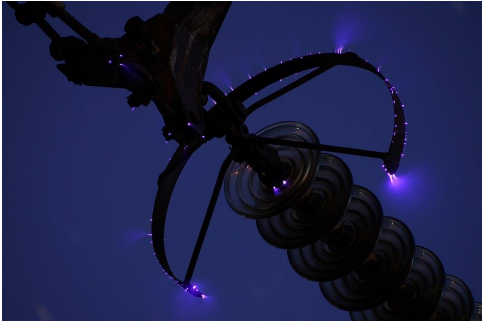
Slika 5. Korona (ionizacijska struja) [4]
