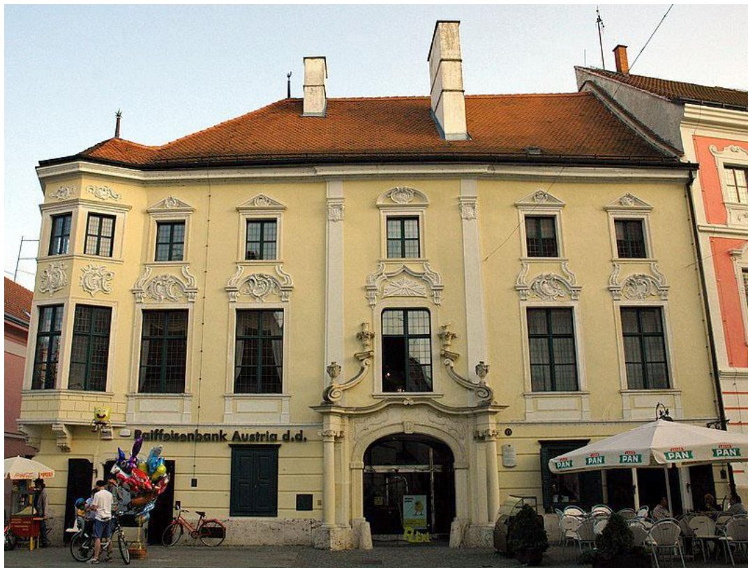
Slika 26. Palača Patačić, Varaždin, 1669. – 1764. , sjeverno pročelje
