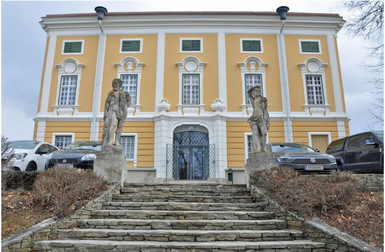
Slika 10. Dvorac Schielleiten, Schielleiten, 1717. – 1731., zapadno pročelje (foto: A. Laznibat)
