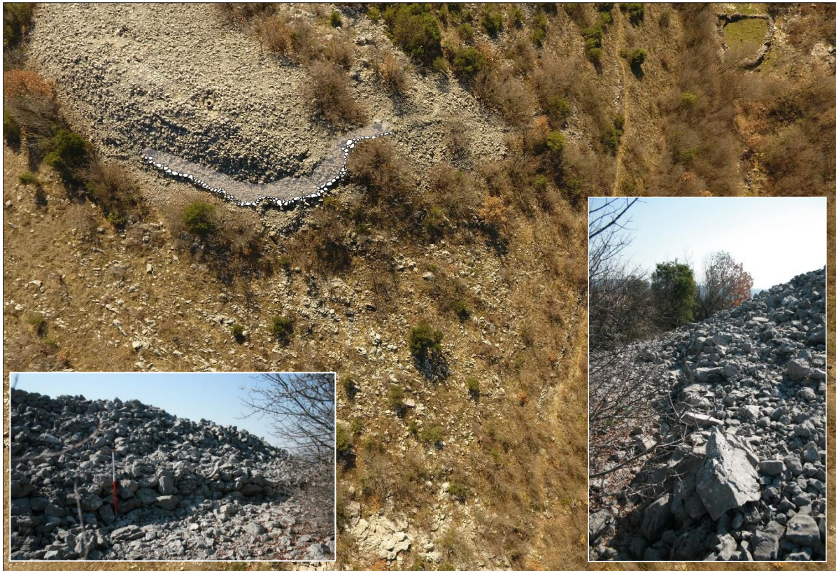
Sl. 281. Posebno formirana platforma ulaznog segmenta Palčeve gomile (foto: T. Tomas)
