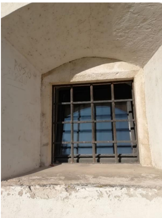
Slika 15: Varaždin, Stari grad – južna kvadratna kula: kameni okvir prozora (fotografija: Ivana Peškan)
