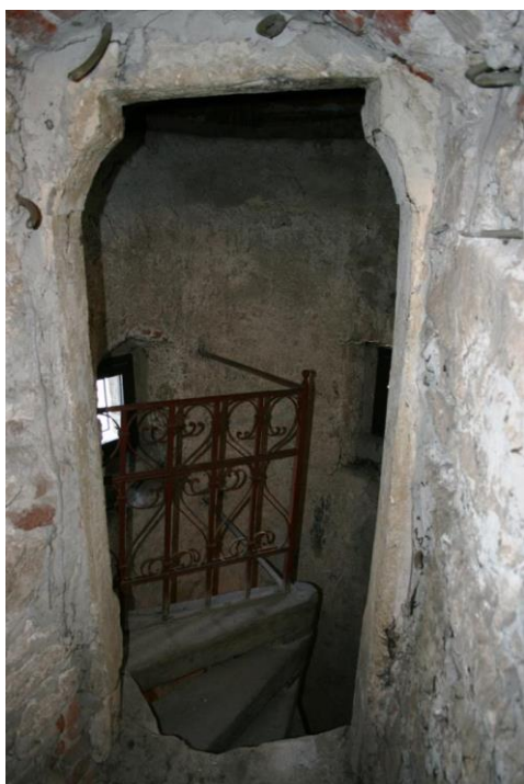
Slika 61 Varaždin, župna crkva sv. Nikole, toranj, kameni okvir vrata, stražnja strana (fotografija: Ivana Peškan)
