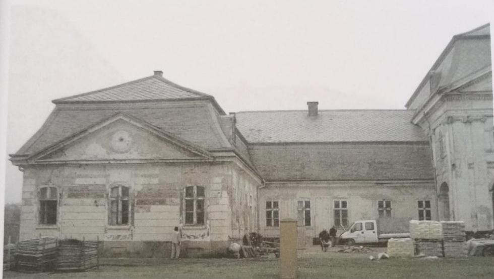
Sjeverno pročelje istočnog krila
