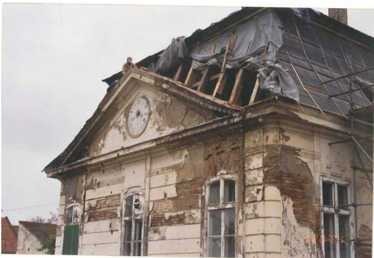
Slika 26. Radovi na rekonstrukciji mansardnog krovišta nad istočnim krilom, izvor: MK-UZKB-KOS
