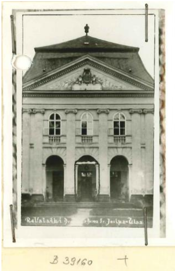
Slika 15. Sjeverno pročelje dvorca, izvor: MK-UZKB-KOS-B 39160
