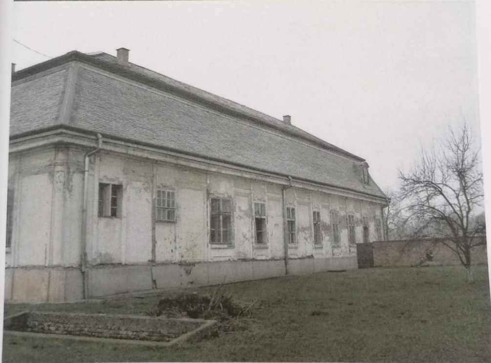
Južno i istočno pročelje istočnog krila
