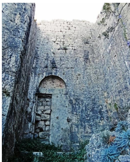
Slika 30. Fotografija zazidanih vrata na utvrđi.
