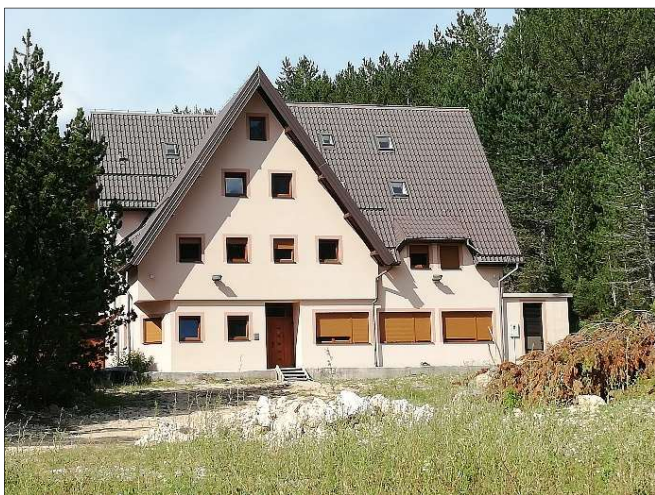
Slika 53. Novoizgrađeni objekt, Masna Luka
