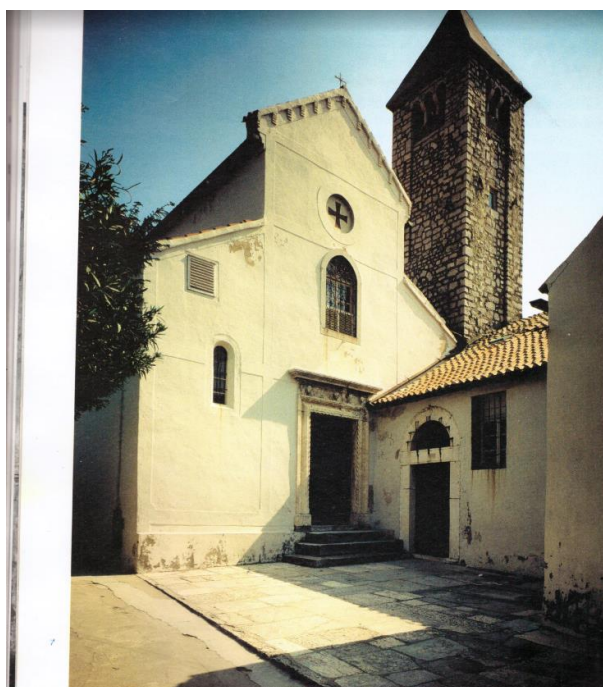
Slika 12. – Pročelje crkve Sv. Andrije (M., DOMIJAN, 2001, 122).
