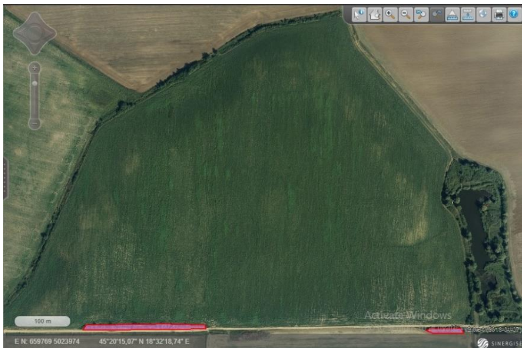
Slika 10. Orto-foto snimak (1:5000) Okmanova brda i akumulacijskog jezera Fabrika s desne strane te potoka Sgorelica s lijeve strane (ARKOD, 2019.)
