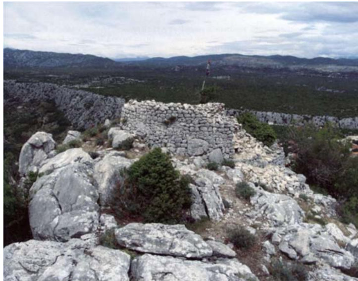
Slika 13. Ostatci kule Avale (I. ALDUK, M. TOMASOVIĆ, 2008, 169).
