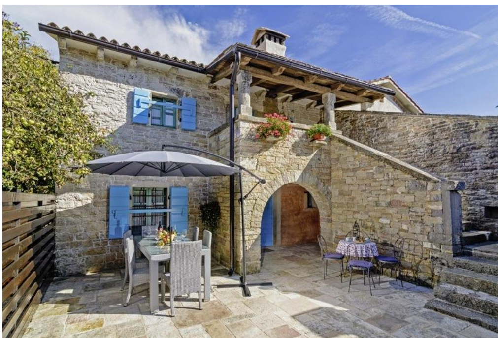
Slika 2. Starinska kamena kuća za odmor
