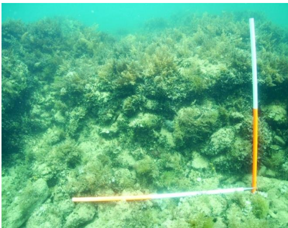
Sl. 32. Uvala Kocište. Kamenomet na čelu lukobrana.
