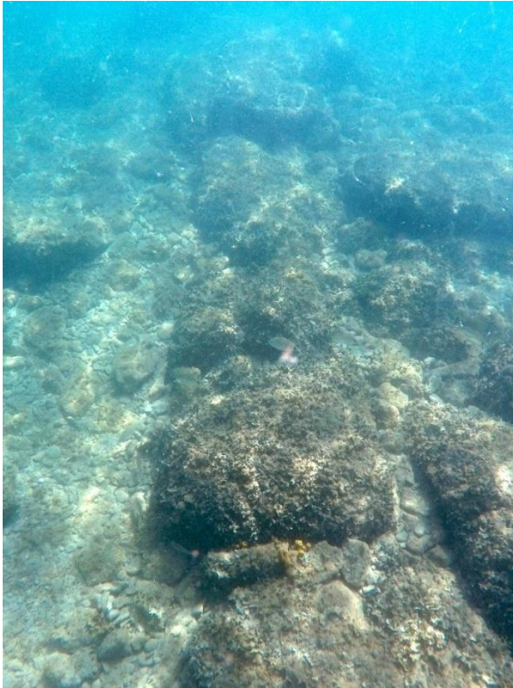
Sl. 135. Blokovi vanjske linije južnog dijela lukobrana (foto: I. Koncani Uhač)
