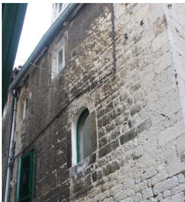
Prilog 21. Primjer zidanja pravlnim klesancima
