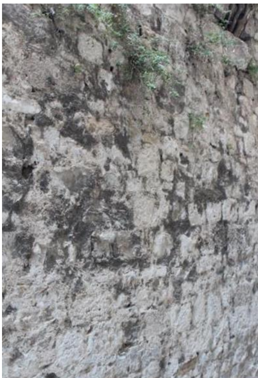
Prilog 20. Primjer zidanja lomljencem
