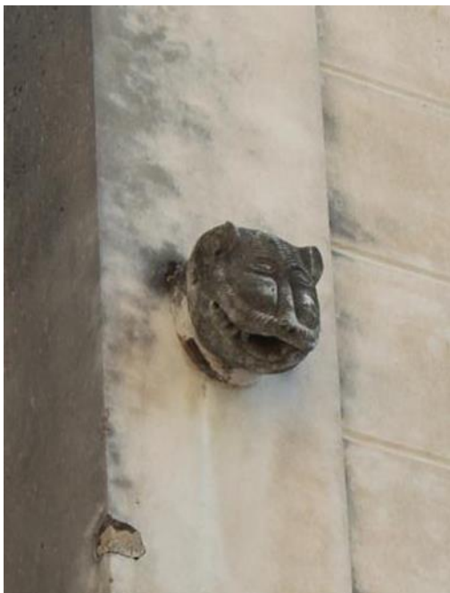
Prilog 31. Kameni odvod u obliku lavlje glave na zidu Gradske kavane na Pjaci
