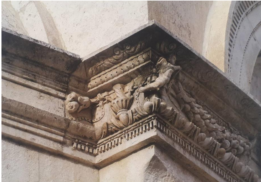
Slika 14: Detalj vijenca sa Malipierove partije , na spoju sa sjevernom apsdom
