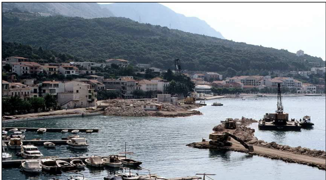
Slika 40. Izgradnja luke u Podgori 546
