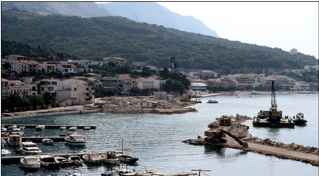
Slika 40. Izgradnja luke u Podgori 546
