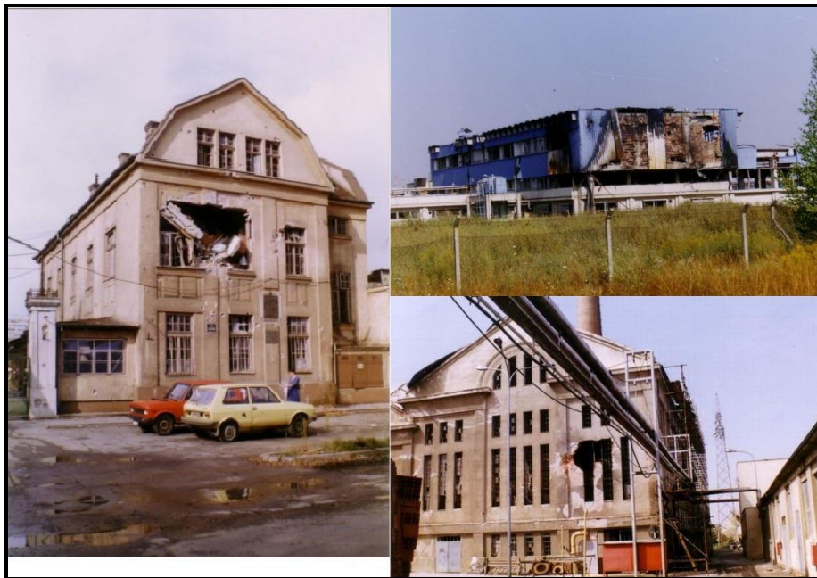
Slika 18. Ratom oštećene tvornice OLT (lijevo), Saponia (desno gore) i toplana (desno dolje)
