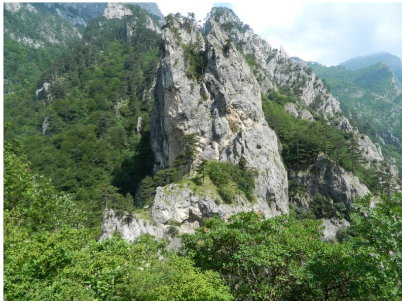
Slike 27 i 28: Urušeni zidovi i podzide ispod grada uz samu rijeku Sutjesku te (dolje) pogled na stijenu nasuprot utvrdi s druge strane rijeke (foto: N. Čuljak).
