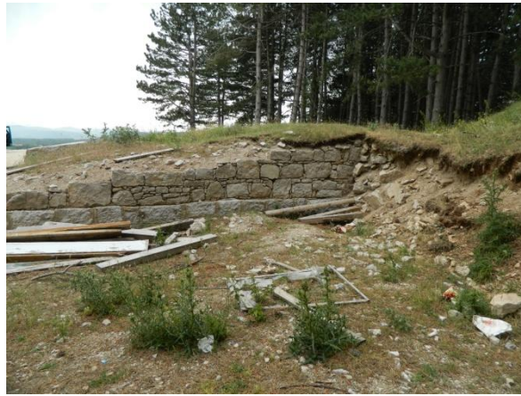
Slika 161: Pogled na bočne nadogradnje koje se pužaju istočno od uzvišenja (foto: N. Čuljak).
