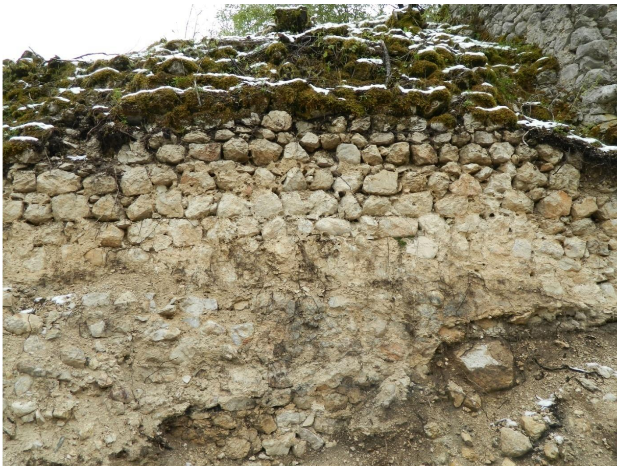
Slika 104: Južni zid Gradine u Idbru (foto: N. Čuljak).
