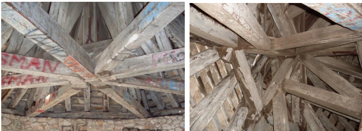
Slike 271 i 272 : Izgled obnovljenog krovišta počiteljske glavne kule (foto: N. Čuljak).
