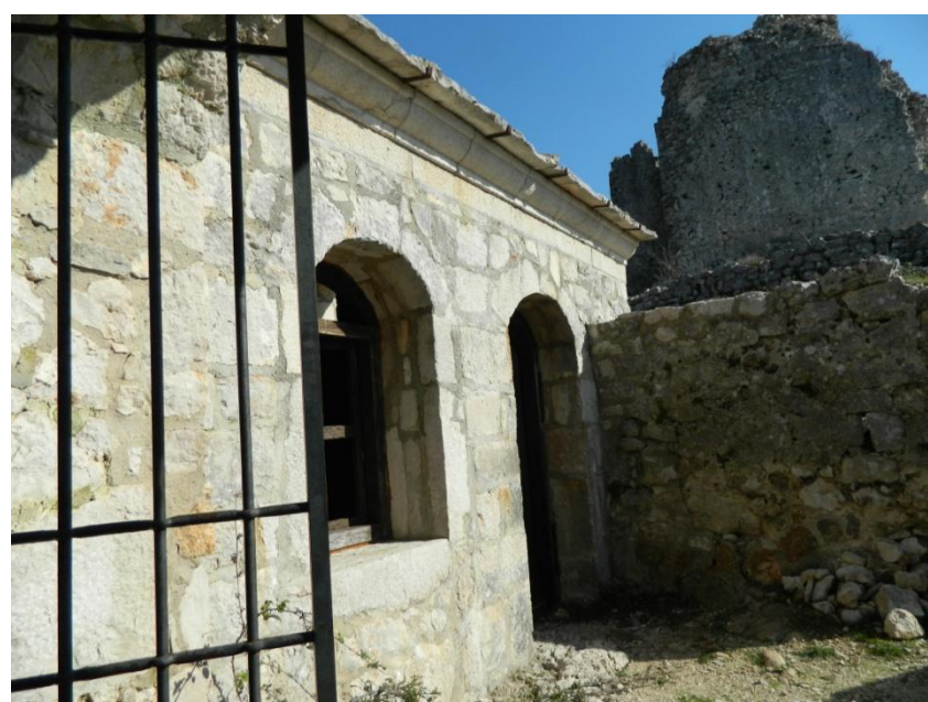
Slike 124 i 125: Renovirani objekti cisterna i desno stražarnica (foto: N. Čuljak).
