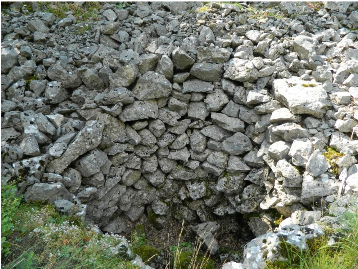
Slika 32: Objekt kružnog oblika koji podsjeća na cisternu (foto: N. Čuljak).
