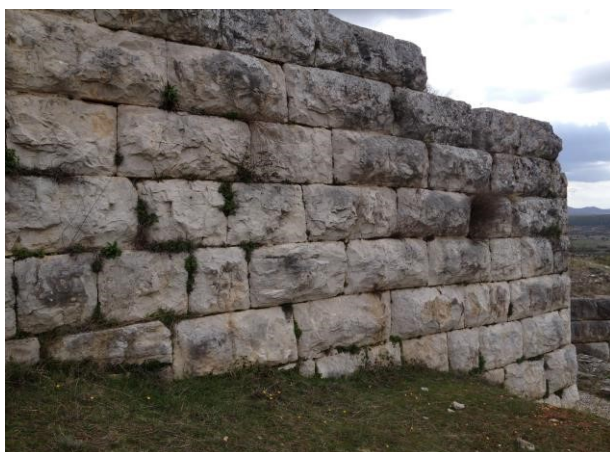
Sl. 7. Zapadni trakt (južni dio)
