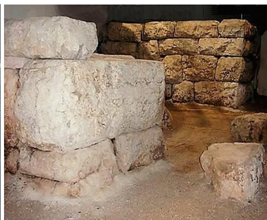
Sl. 30. Ostatci monumentalnog ulaza
