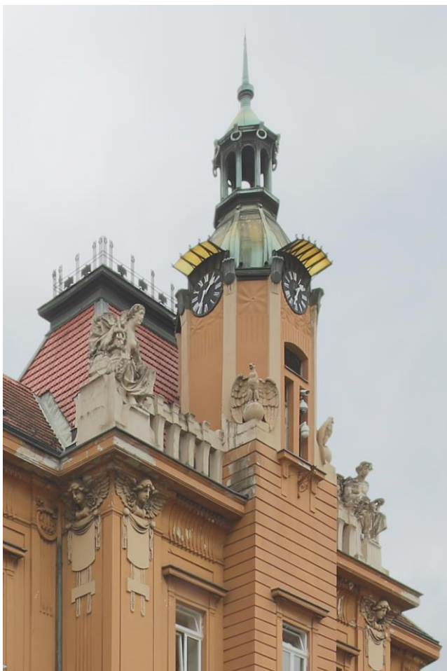
44. Zgrada Trgovačko – obrtne komore (Zagreb, Trg maršala Tita 8), detalj pročelja (foto: Z. Bogdanović, 2015.)
