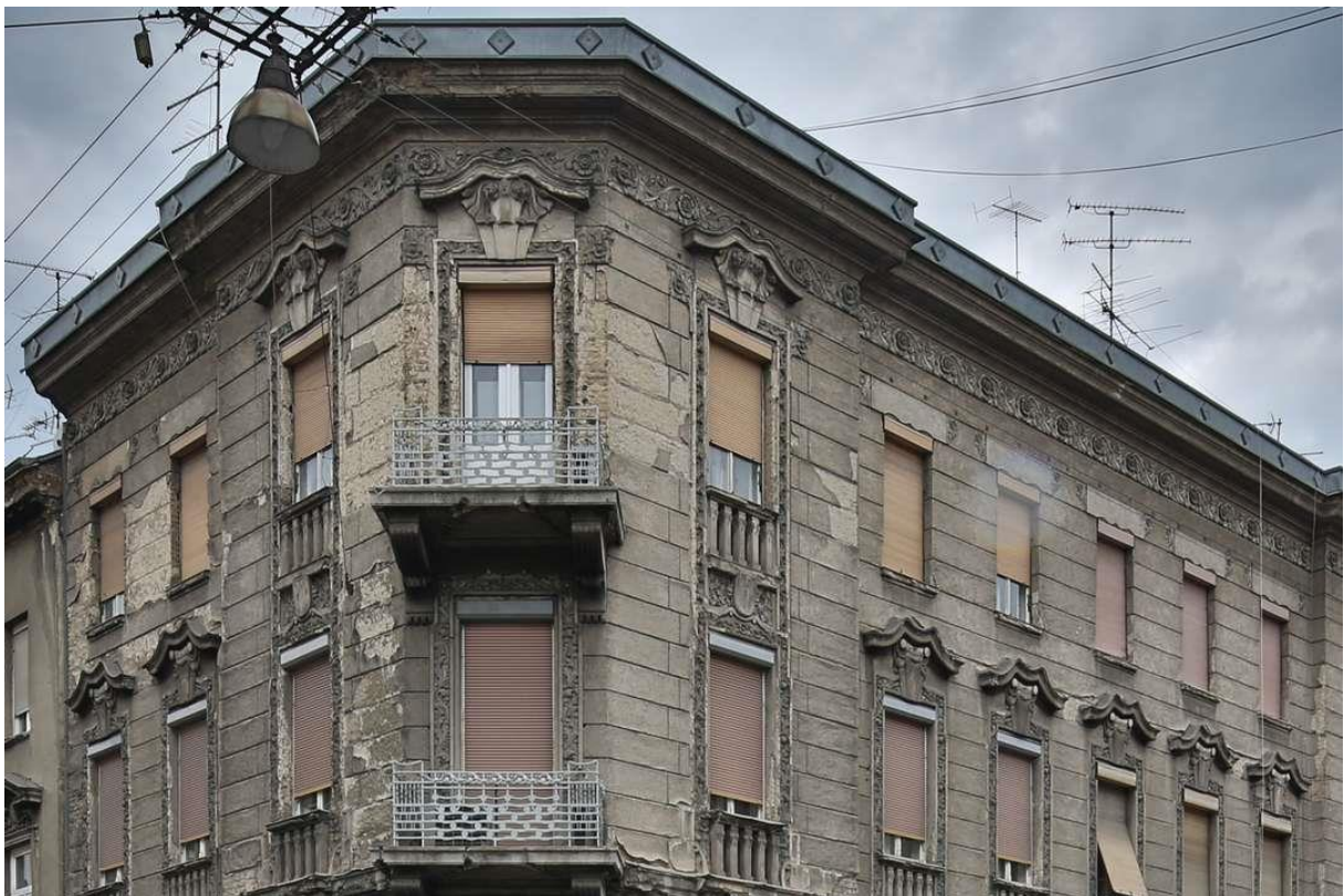
299. Zgrada Zadobošek (Zagreb, Đorđićeva), ulično pročelje, detalj (foto: Z. Bogdanović, 2015.)
