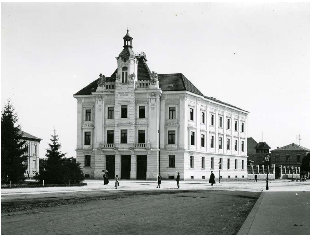
40. Zgrada Trgovačko – obrtne komore (Zagreb, Trg maršala Tita 8) početkom 20. st., sjeverno pročelje (Muzej grada Zagreba, inv.br. MGZ 5884, foto: nepoznato, 1903.)
