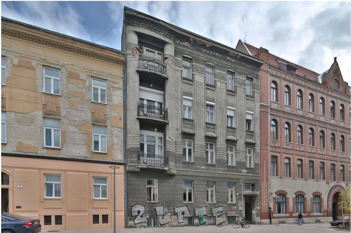
309. Zgrada Rozsay (Zagreb, Kurelčeva 3) unutar istočnog uličnog niza (foto: Z.Bogdanović, 2015.)
