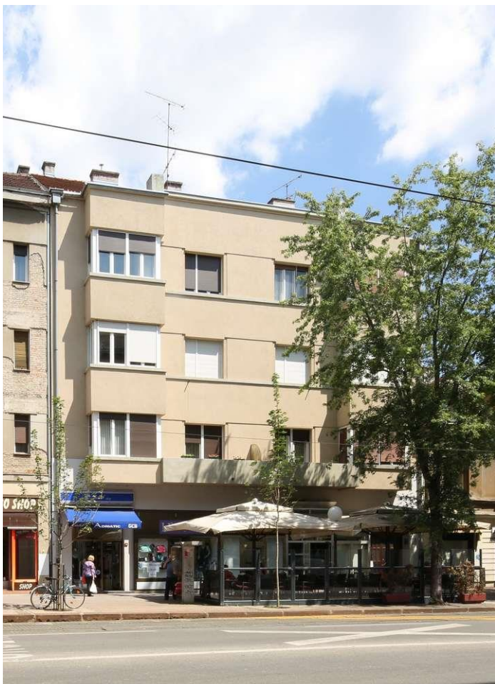
601. Zgrada Zuber (Zagreb, Vlaška 95), ulično pročelje nakon obnove 2015. godine (foto: Z. Bogdanović, 2015.)
