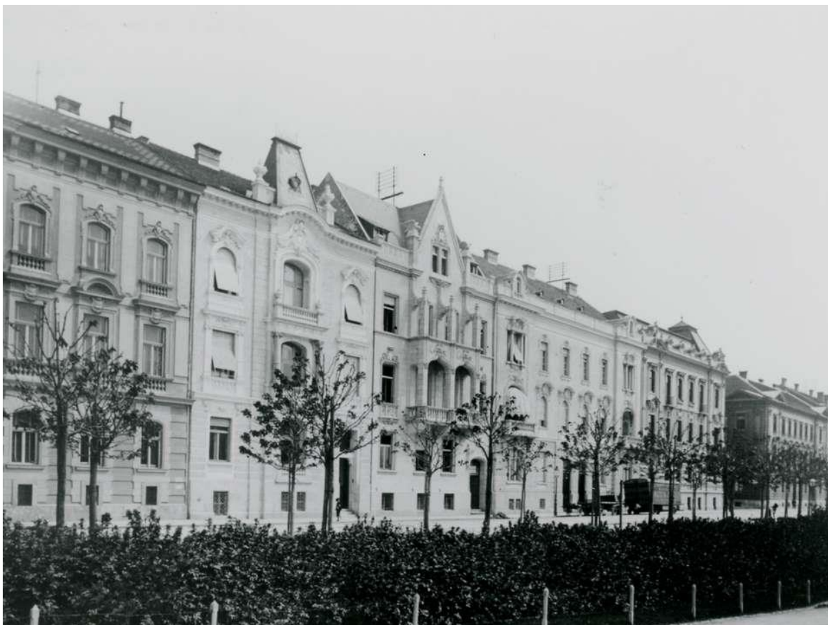
52. Zgrada Feller (Zagreb, Trg kralja Tomislava 4) treća s lijeva na fotografiji istočne strane Trga kralja Tomislava oko 1910. (Muzej grada Zagreba, inv.br. MGZ fot. 8294, oko 1910.)
