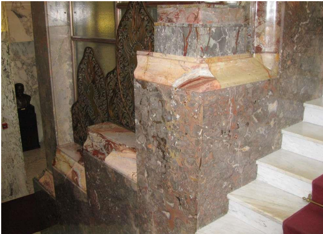
464. Detalj stubišta s dizalom u sredini (foto: M. Strugar, 2014.)
