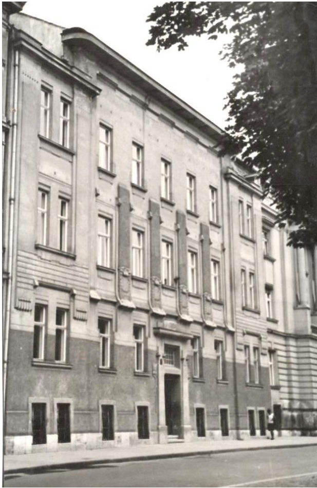
57. Zgrada Doma Mirovinskog zavoda članova Hrvatskog zemaljskog kazališta (Zagreb, Trg Mažuranića 12), ulično pročelje šezdesetih godina 20.st. (Konzervatorski odjel u Zagrebu, fototeka)
