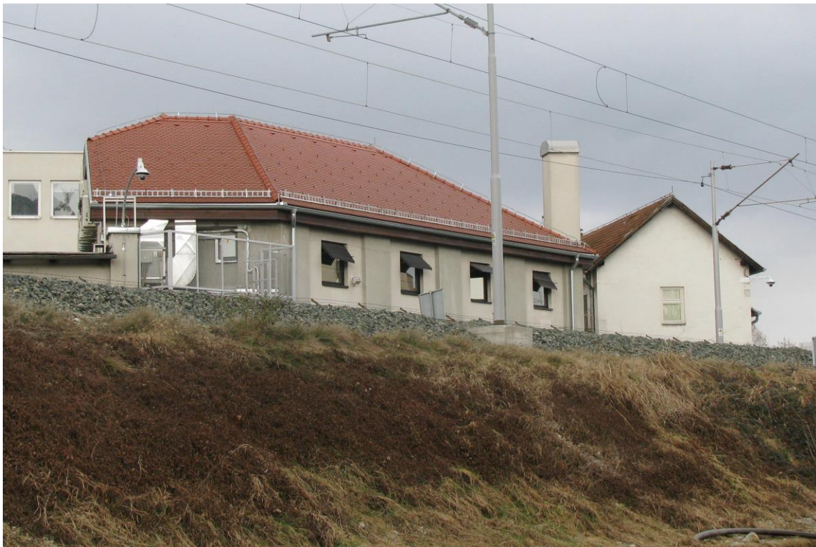
486. Pogled na dogradnje uz Koturašku ulicu sa zgradom skladišta u prvom planu, današnje stanje adaptacijama izmijenjeno u odnosu na izvorno (foto: M. Strugar, 2016.)
