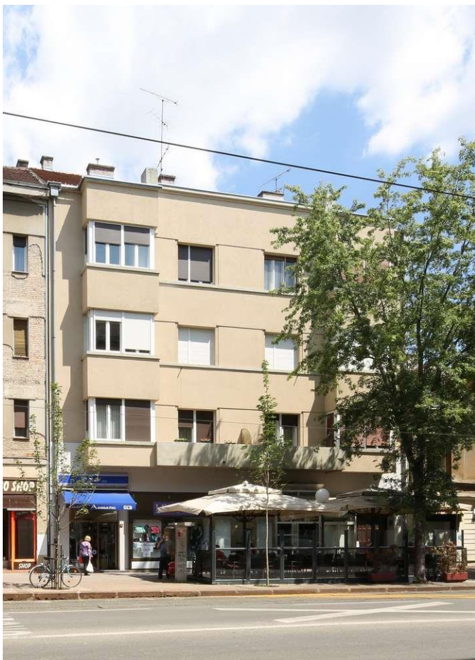
601. Zgrada Zuber (Zagreb, Vlaška 95), ulično pročelje nakon obnove 2015. godine (foto: Z. Bogdanović, 2015.)
