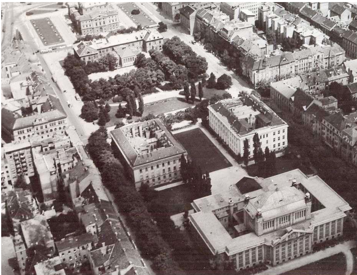
87. Pogled na zapadni krak Zelene potkove sa zgradom Nacionalne sveučilišne knjižnice u prvom planu i zgradama nekadašnjeg Fizikalnog instituta i Kraljevskog sveučilišnog ludžbenog zavoda iza nje (Konzervatorski odjel u Zagrebu, inv.br.25546, foto: Agefoto Zagreb)
