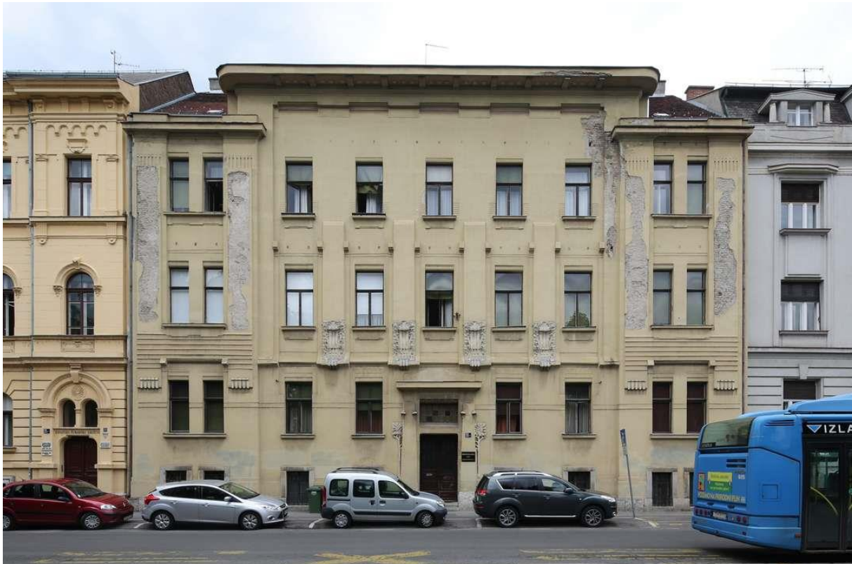
289. Dom Mirovinske zaklade članova Hrvatskog zemaljskog kazališta (Zagreb, Trg Mažuranića 12), ulično pročelje (foto: Z. Bogdanović, 2015.)
