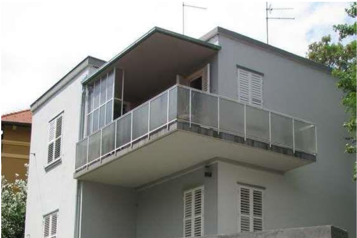
579. Ulično pročelje, jugoistočni ugao: balkon na prvom katu, (foto: M. Strugar, 2012.)
