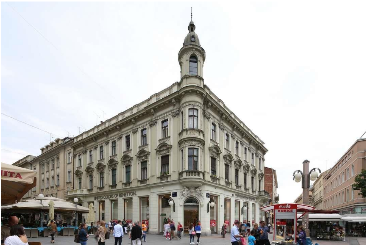
195. Zgrada Farkaš (Zagreb, Bogovićeveva 9), ulična pročelja, današnje stanje (foto: Z. Bogdanović)
