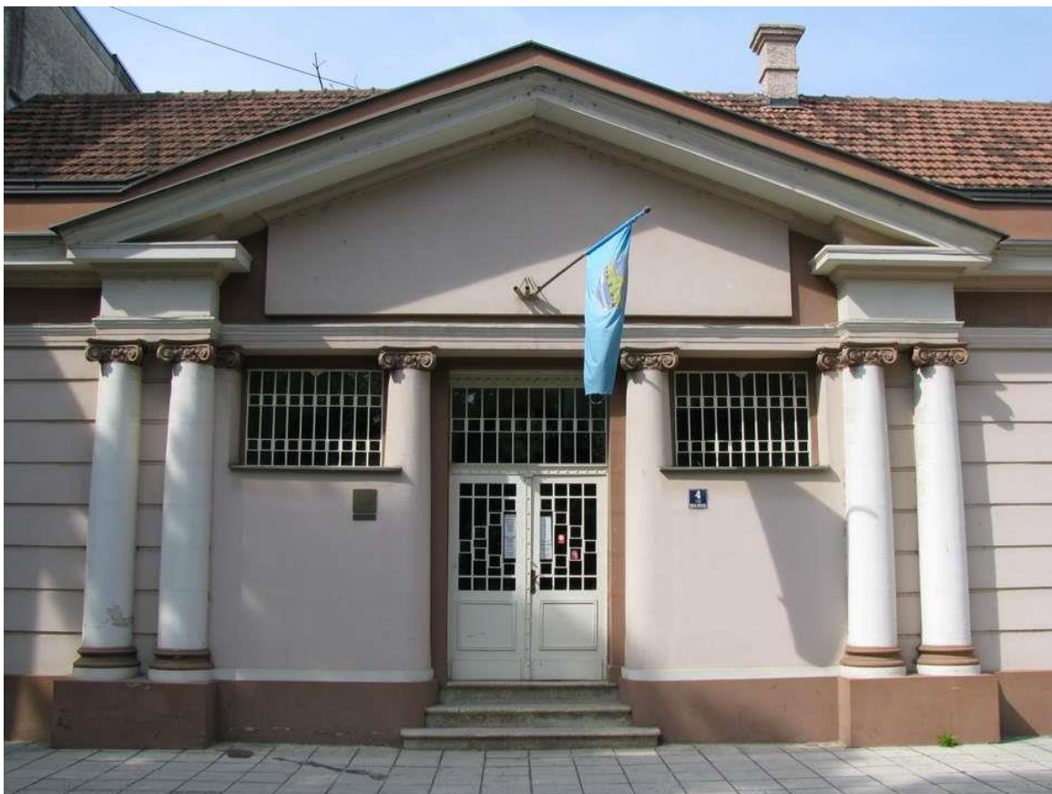
415. Glavno ulično pročelje, detalj (Foto: M. Strugar, 2009.)
