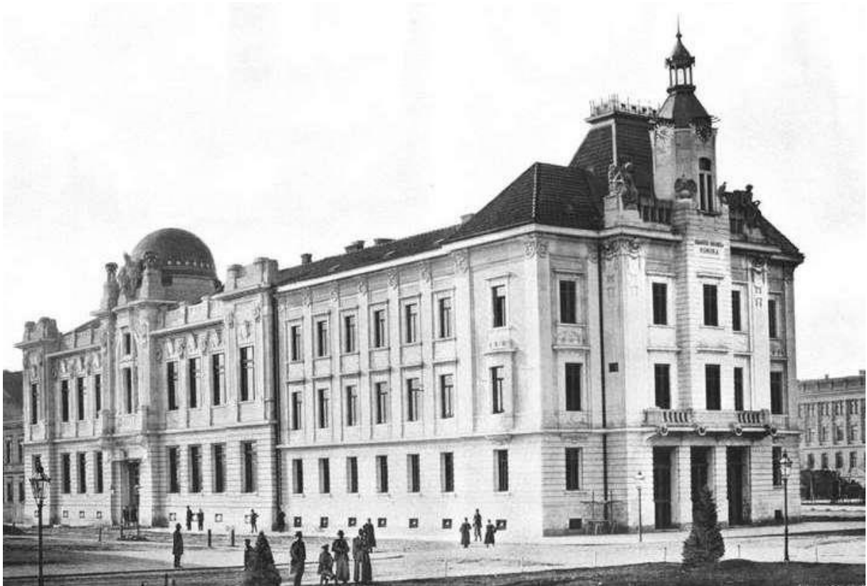
246. Zgrada Trgovačko-obrtne komore i muzeja 1905. godine (1905./II), Palais des Handels- und Gewerbekammer in Agram , Wiener Bauindustrie Zeitung, 22 (26): tabla 3, Beč
