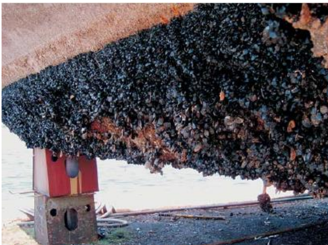
Slika 19 – Obraslo dno plutajuće platforme (I. JURAGA, I. STOJANOVIĆ, T. NORŠIĆ, 2007, 279.)
