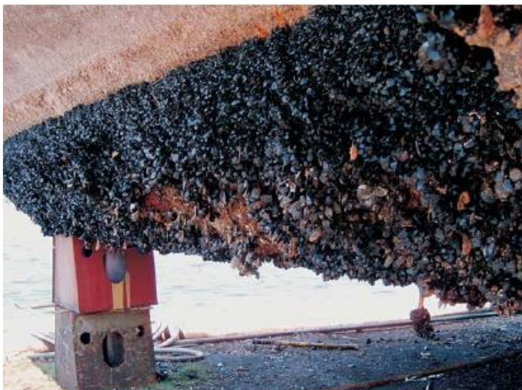
Slika 19 – Oblaslo dno plutajuće platforme (I. JURAGA, I. STOJANOVIĆ, T. NORŠIĆ, 2007, 279.)
