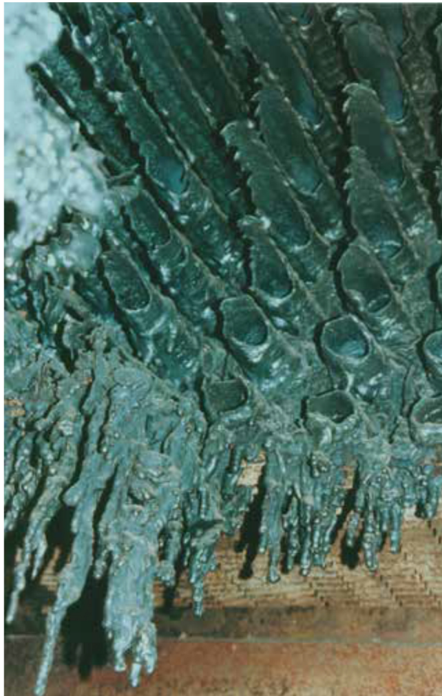
Slika 17. Posljedice požara u generatoru pare na ispušne plinove[31, str. 14.]
