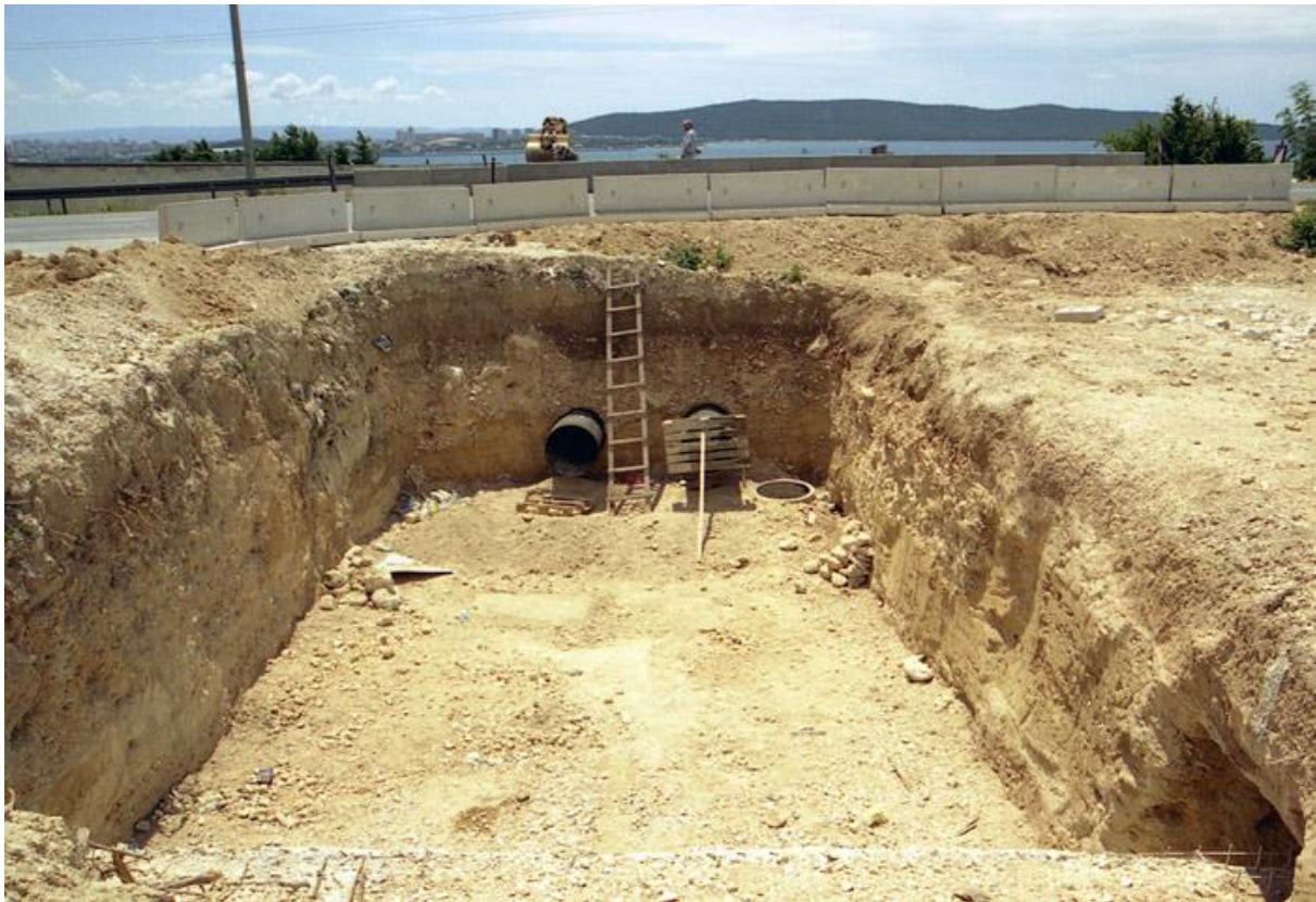
Slika 24: Glavni cjevovod Kaštela - Trogir - iskop ispod magistrale ( Izvor: URL11 ).
