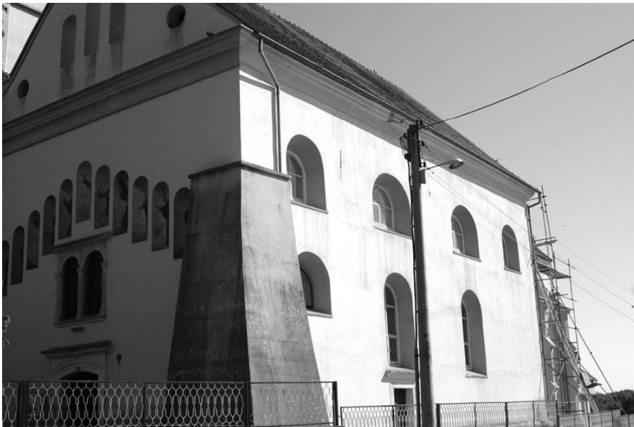
Slika 23: Radovec, Kapela Bl. Djevice Marije, pročelje i bočni zid, Foto: I. Potočnik, 2013.
